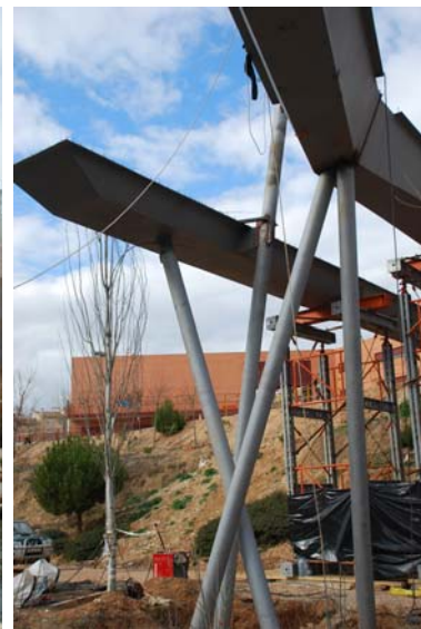
Fig. 11 a) Concepción estructural definitiva de la pasarela, vista desde el parque del Alamin; b) Cuatro fustes inclinados durante el montaje
