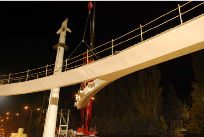
Fig. 7 Izado de la viga cajón del vano principal
