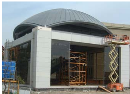
Figura 3. Vista exterior del edificio en el Observatorio Astronómico.
