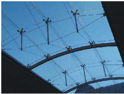
Figura 1. Vista inferior de la cubierta del patio central del Tanatorio de la M-30.
