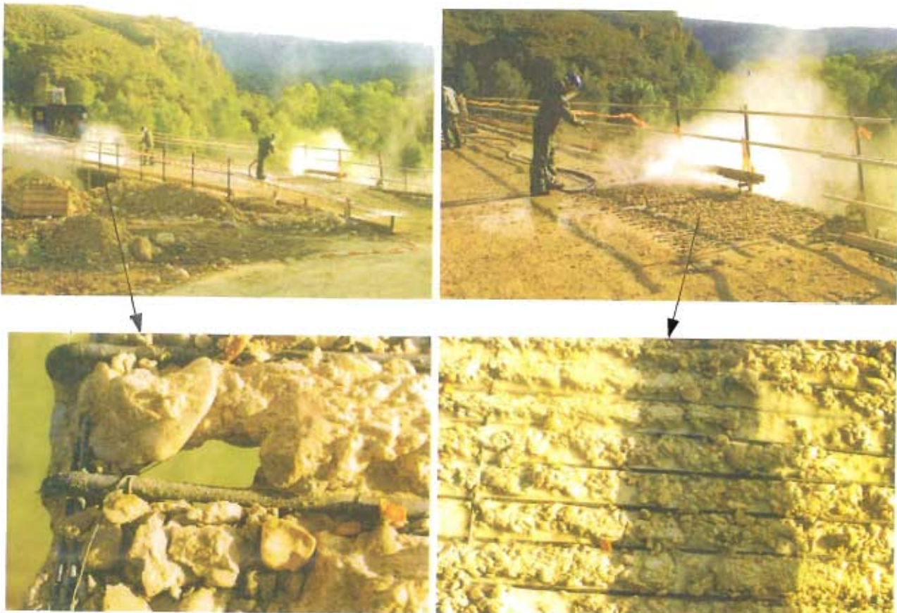
Figura 12.- Ejecución de rozas mediante hidrodemolición.
