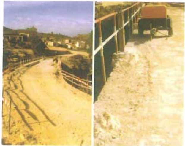
Figura 11.- Demoliciones de la capa de rodadura y de las impostas.
