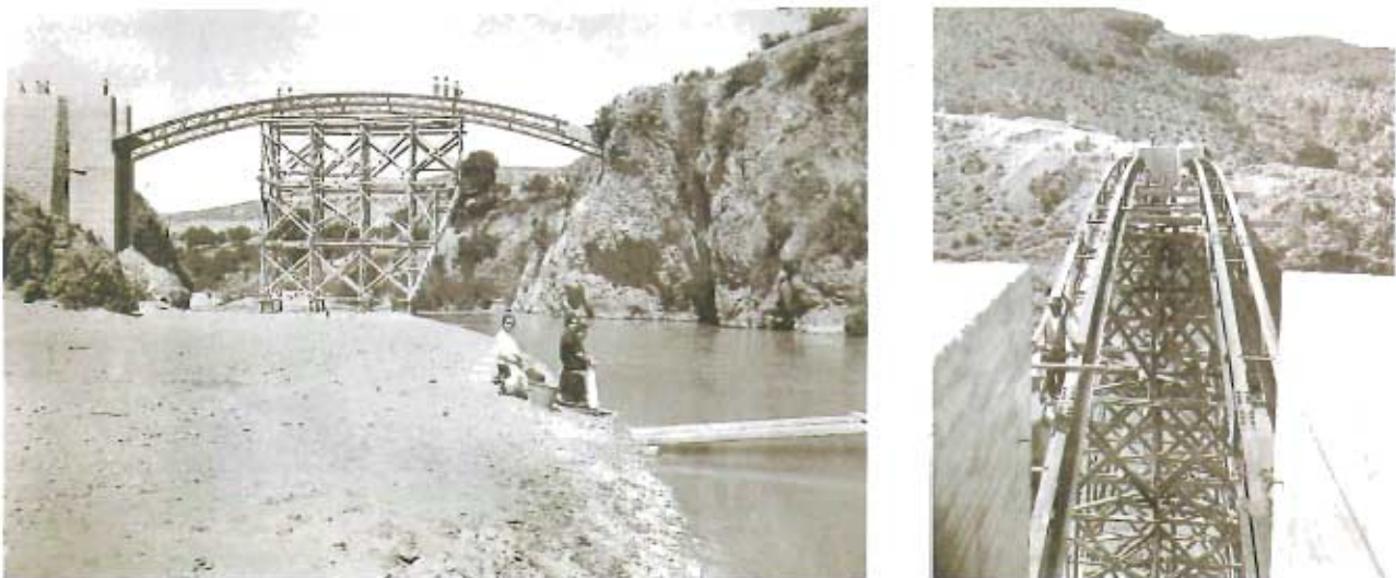
Figura 2.- Construcción del puente original con cimbras autoportantes (Fotografías atribuidas a Luis Escobar).
