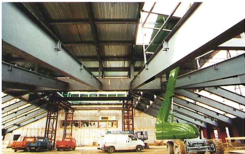
Fig. 6: Cordón superior apoyado en una estructura auxiliar durante el montaje.
