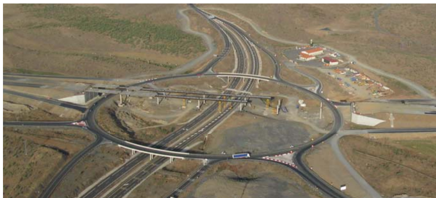
Fig. 1 Vista aérea del enlace de la autovía de La Plata con la autovía autonómica EX108
