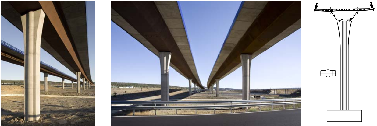
Fig. 3 Pilas; a) y b) Vista general tras la construcción; c) Alzado y sección transversal
