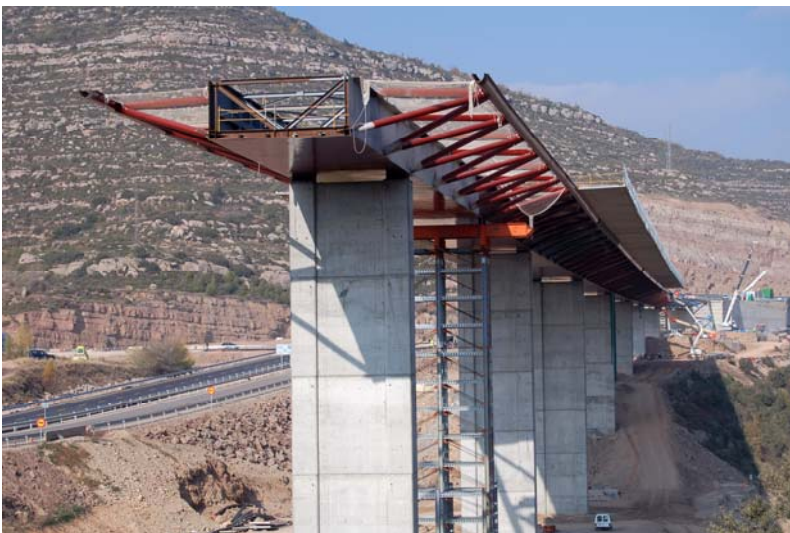
Fig. 5 Vista parcial del viaducto con diferentes fases de la construcción (Fotografía: Peter Tanner)
