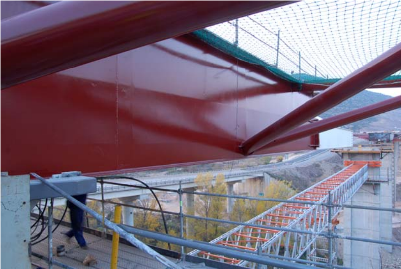
Fig. 6 Lanzamiento de la estructura metálica (Fotografía: Peter Tanner)
