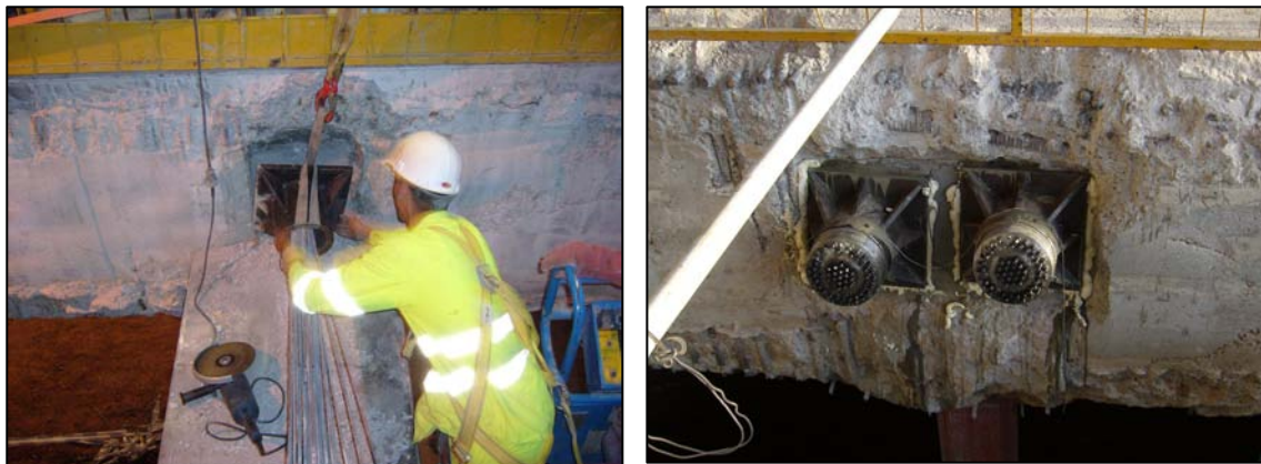
Fig. 11 Colocación de cabezas de retesado
