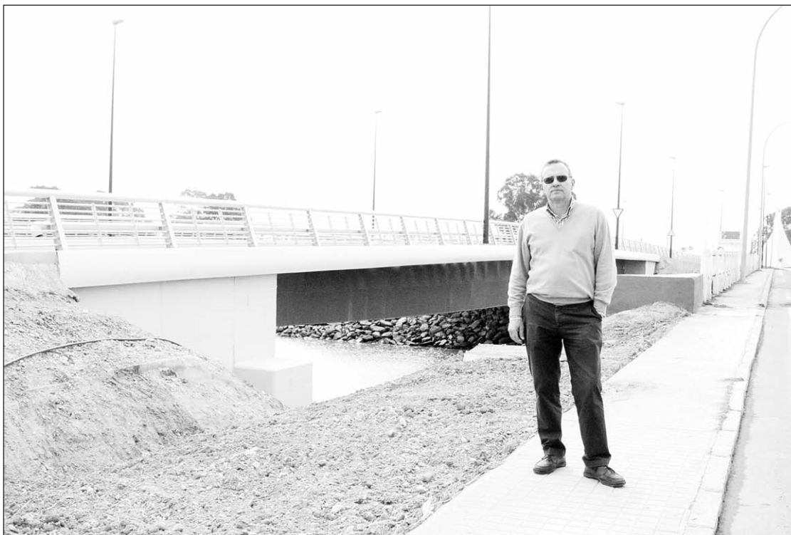
Rafael Pérez Cameselle, responsable de ejecución de obra civil de Germán Gil Senda.
