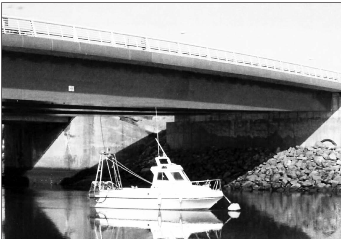
Nuevo puente sobre el Estero de Canela.
