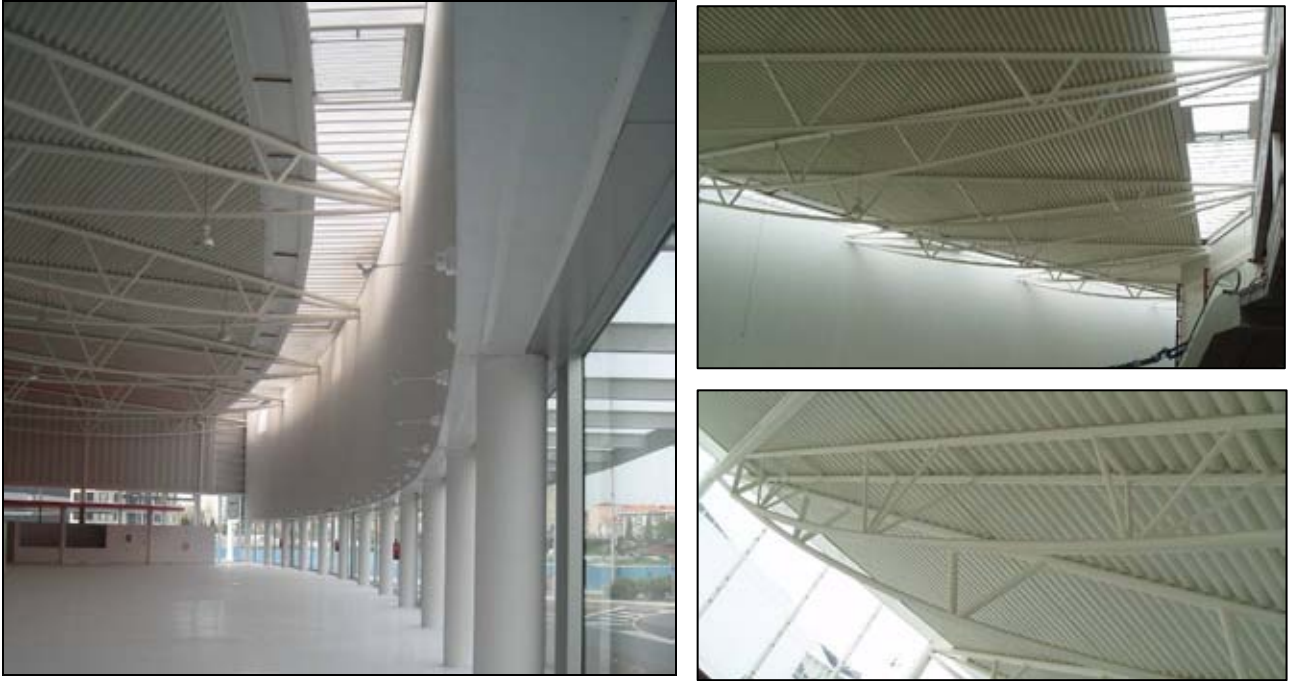
Fig. 7) Acceso principal terminado
