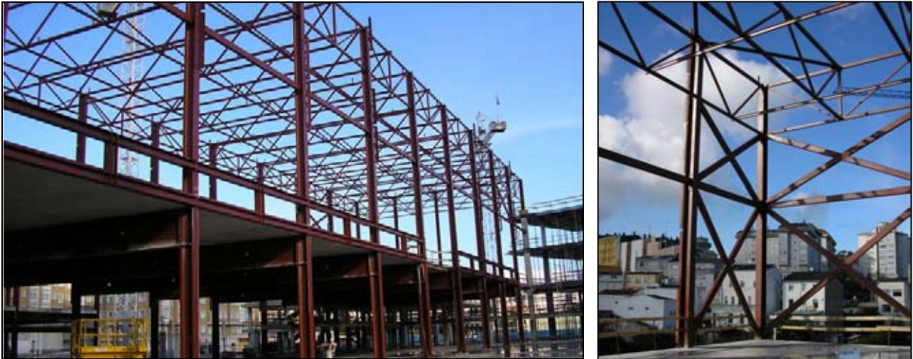
Fig. 11) Cubierta del prisma durante su ejecución y detalle de las cruces de arriostramiento
