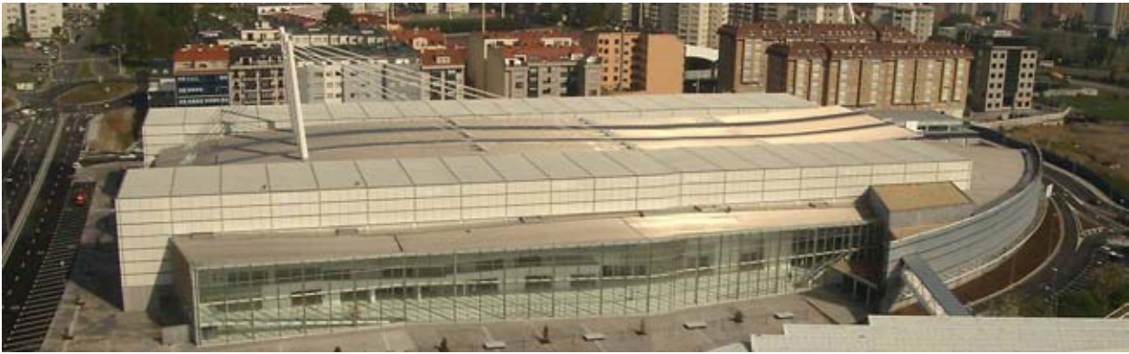
Fig. 2) Vista del conjunto
