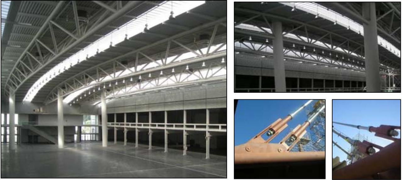
Fig. 13) Vistas interiores de la cubierta central y detalles de tirantes
